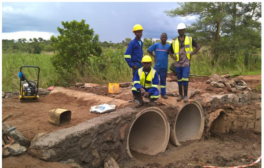
Die Arbeiten am vier Kilometer langen Zufahrtsweg beginnen an den Brücken.
