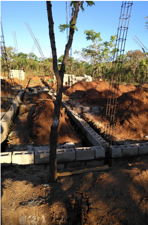
Die Fundamente der neuen Gesundheitsstation sind gelegt.
